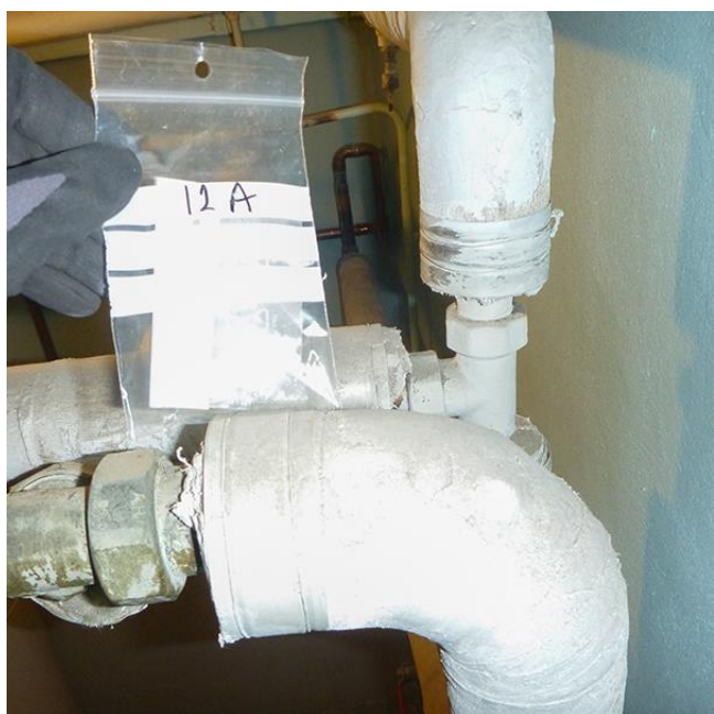
Asbestholdig rørisolasjon i bend, rom 023. Prøve 12.
