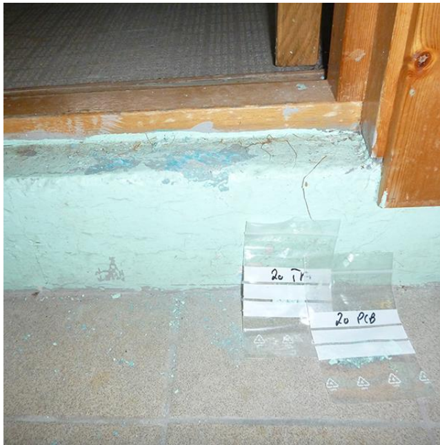
Rom 035: prøve 20. Veggmalings inneholder tungmetaller og klassifiseres som lettere forurensset.
